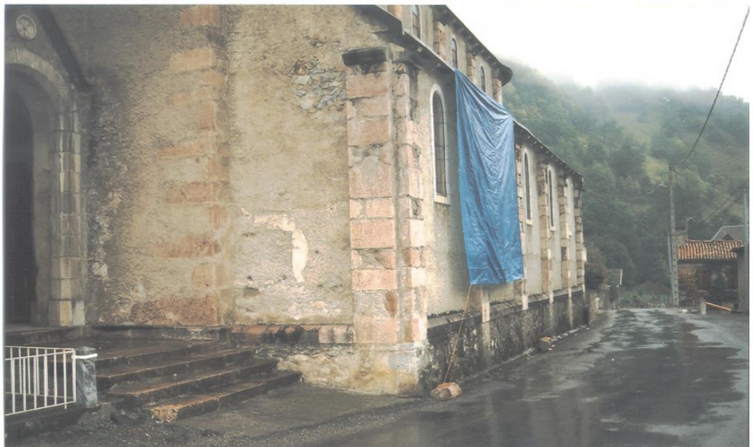
photo 3 : Les deux blocs décrochés des contreforts ayant endommagé la toiture servent ici au maintien de la bâche anti-infiltration .
